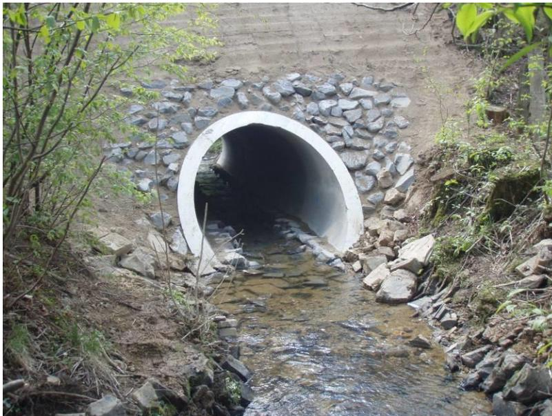
Abb. 15: Neuer Rohrdurchlass Holenfeld/Derenbach mit Geschiebesohle (Quelle: eigene Aufnahme)
