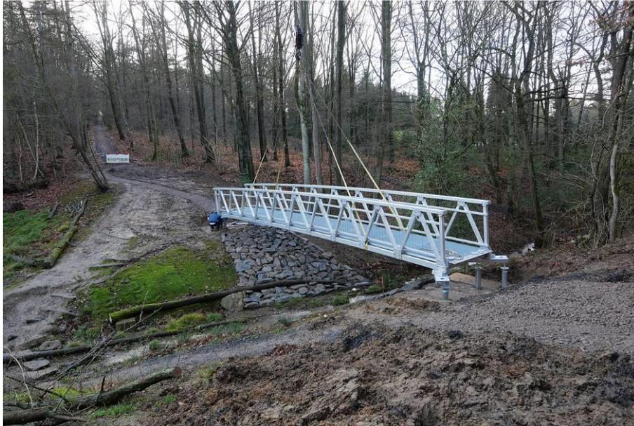
Abb. 13: Gewässerquerung mittels Aluminiumbrücke (Quelle: witten.de)
