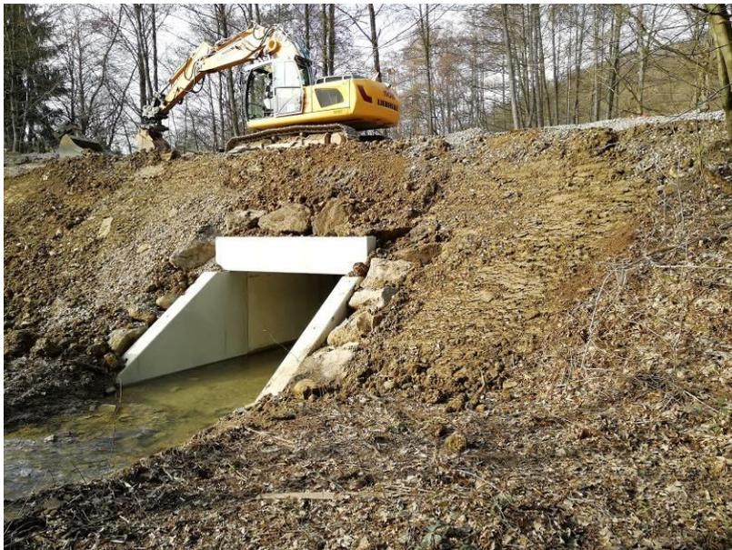
Abb. 16: Neuer Rechteckdurchlass in Neunkirchen-Seelscheid Ohmerath mit späterer Geschiebesohle (Quelle: eigene Aufnahme)
